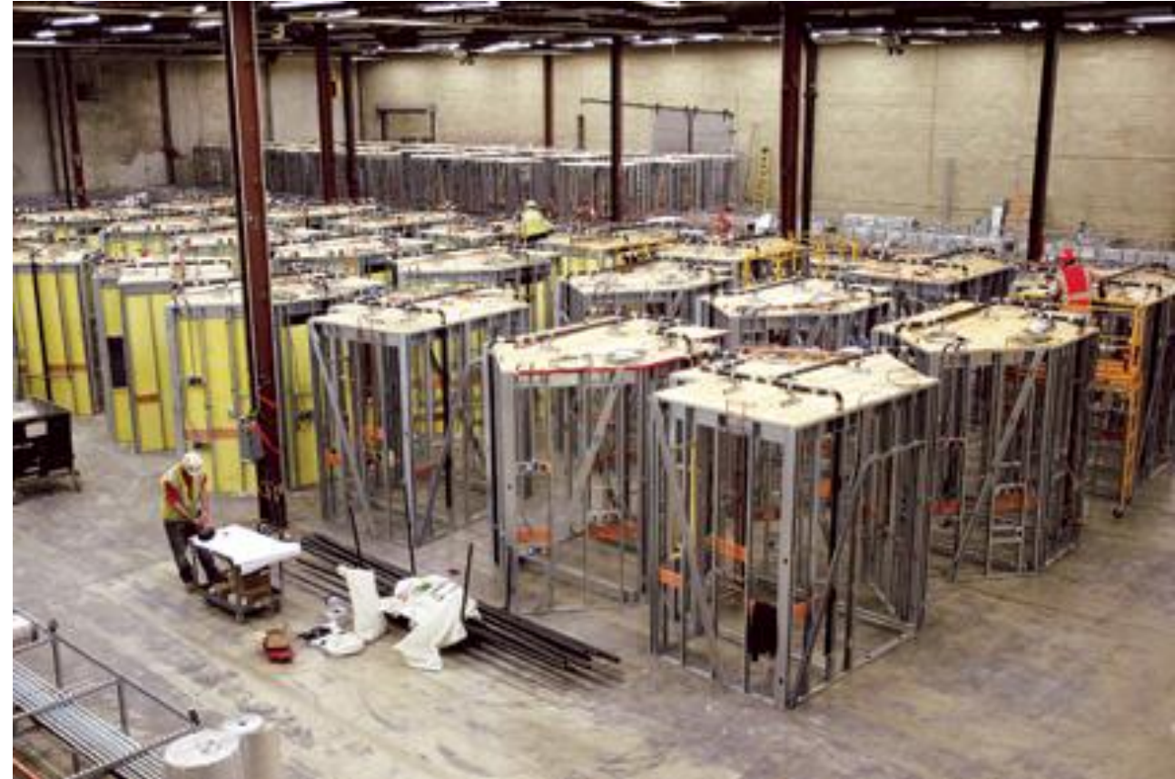
Salles de bains normalisées Miami Valley Hospital A Prefab Story (Skanska, 2010)
